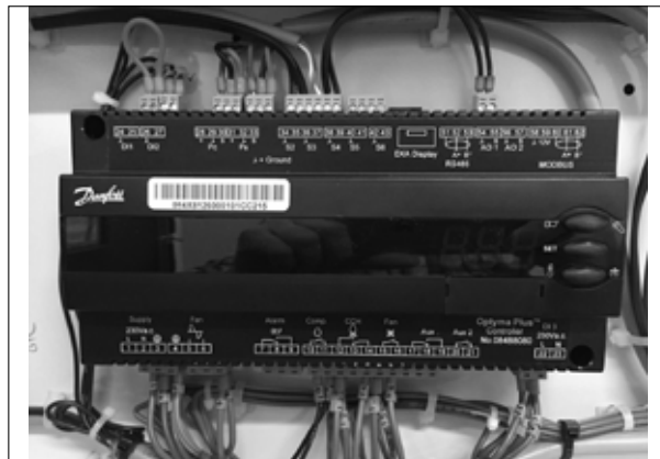
Bilde 4: Normal kabling
