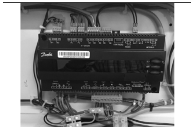
Bild 5: Tillfälliga anslutningar
