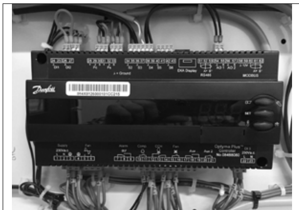
Εικόνα 4: Κανονική καλωδίωση
