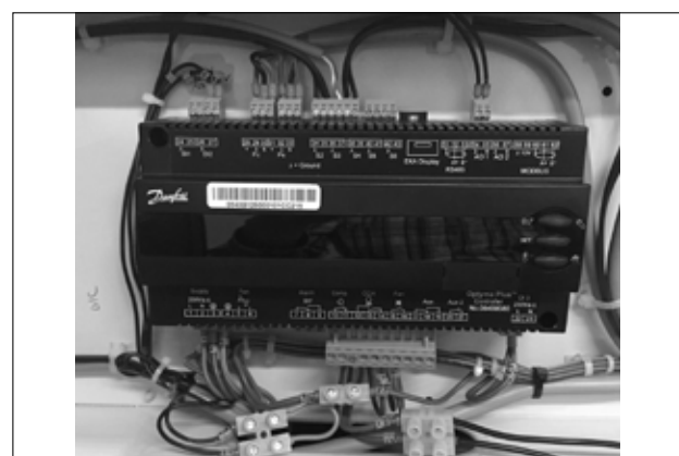
Billede 5: Midlertidig ledningsføring
