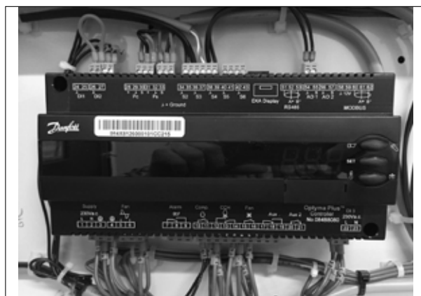
Bild 4: Normale Verdrahtung
