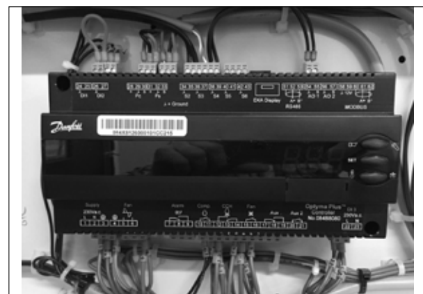
Rysunek 4: Okablowanie normalne
