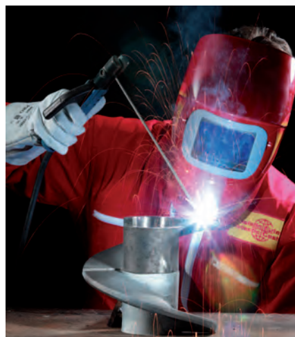
Сварка методом MMA
